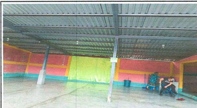
Foto1: Ejecución de cubierta de lámina en el salón del segundo nivel de la escuela. Con esto se logra que ya no se filtrará el agua.
