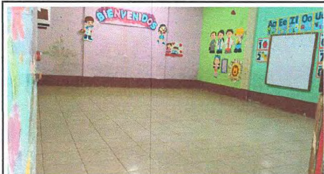
Foto 7: Piso, finalización en la instalación de piso cerámico en el aula dos del primer nivel de la escuela.
