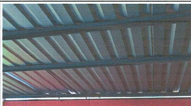
Foto 2: Instalación de láminas en el área del segundo nivel de la escuela, para que el agua no se filtre.
