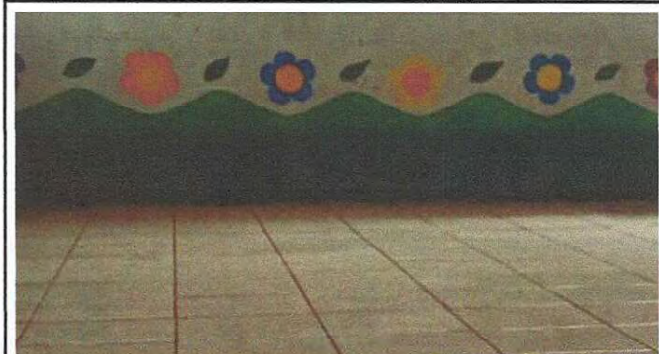
Foto 10: Piso, finalización en la instalación de piso cerámico en el aula cinco de la escuela.
