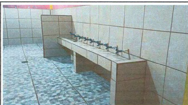
Foto 14: Finalización en la instalación de cerámico en lavamanos y paredes de los sanitarios del segundo nivel de la escuela.
