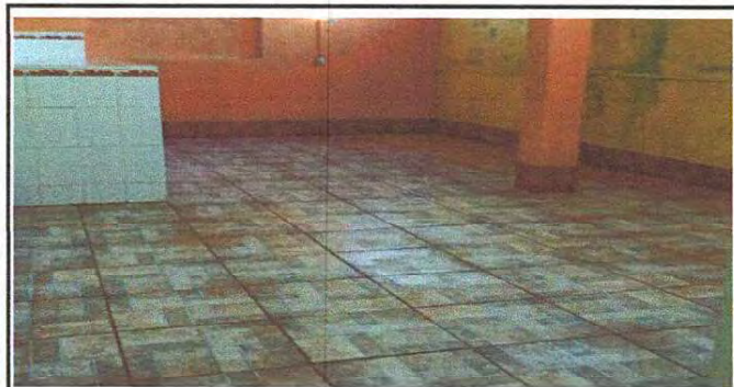
Foto 11: Piso, finalización en la instalación de piso cerámico antideslizante en la cocina de la escuela.
