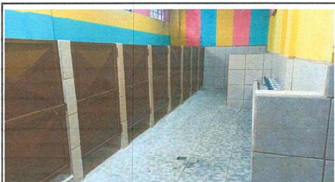
Foto13: Finalización en la instalación de cerámico en lavamanos y paredes de los sanitarios del primer nivel de la escuela.
