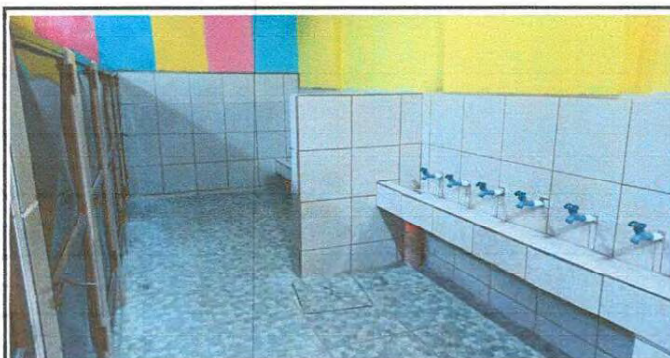
Foto 5: Piso, finalización en instalación de cerámico en los sanitarios del primer nivel de la escuela.
